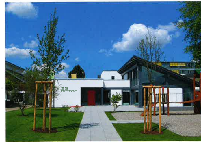
Das „Bistro 33“ wurde 2016 in der Fellbacher Ausstellung neu gebaut und lädt zum Entspannen bei einem leckeren Essen oder einem belebenden Kaffee ein. Fotos: Eigenheim und Garten
